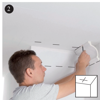
2 Marker hjørnet med et kryds
