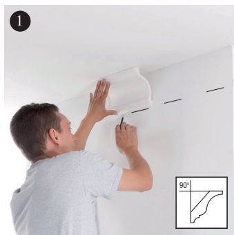
1 Marker stuklistens placering på væggen
