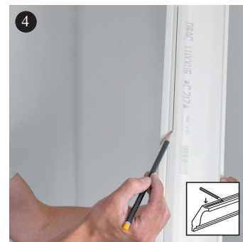
4 Marker listens overdel og vend denne imod bunden af skærekassen.
