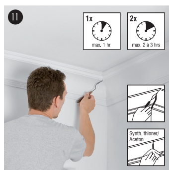
11 Fjern overskydende lim i samlinger med en spartel inden max. 1 time. Gentages efter 2-3 timer. Rens med syntetisk fortynder/acetone
